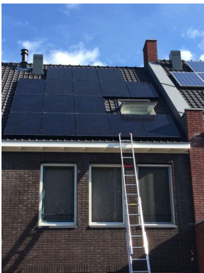
Voorbeeld met 16 x type AEG zonnepanelen, type AS-M606B 300WP mono full black.
